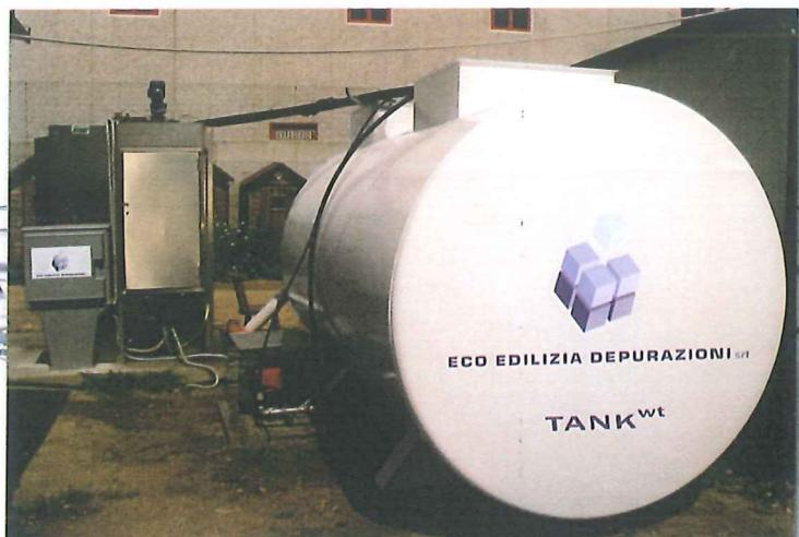
La depurazione a fanghi attivi è un processo biologico completamente naturale e sicuro. Le sostanze inquinanti entrano nelle vasche di ossidazione dove sono aggredite ed eliminate da colonie di batteri, i cosiddetti fanghi attivi. Una volta depurata, la miscela di acqua e fango passa nel comparto di sedimentazione dove avviene la separazione. Il fango, si deposita sul fondo ed è aspirato e ricircolato nelle vasche di ossidazione. L'acqua, ormai depurata, è scaricata verso l'uscita.
